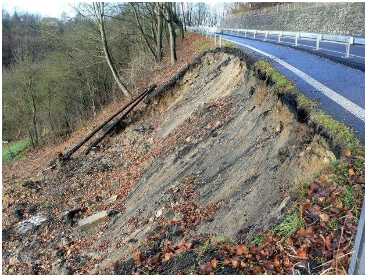
Utržená krajnice u Dolánek na silnici z Turnova na Harrachov. | foto: Petr Kyncl, Česká geologická služba
